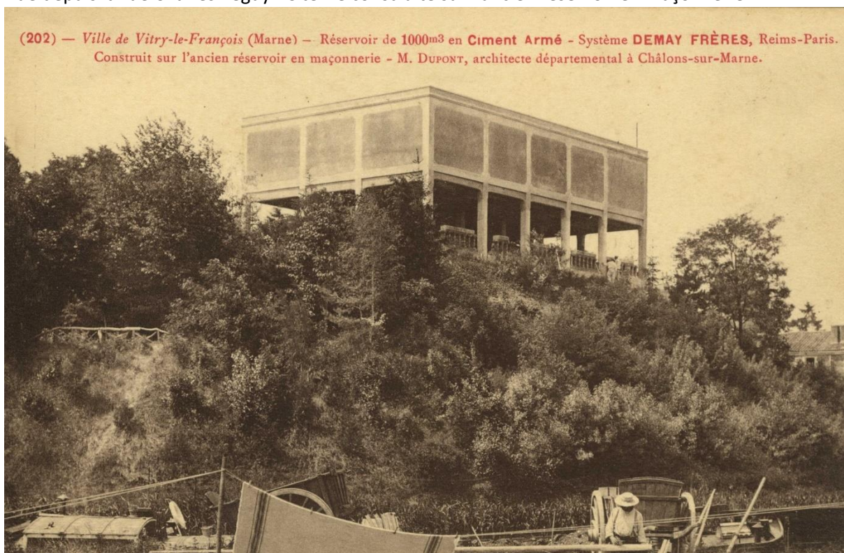
Vue depuis la rue Charles Péguy : Citerne construite sur l'ancien réservoir en maçonnerie
